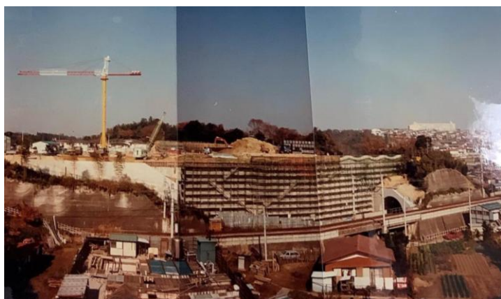
学校工事の様子
