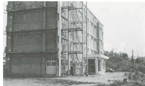
建設中のA棟、職員玄関が見えます
