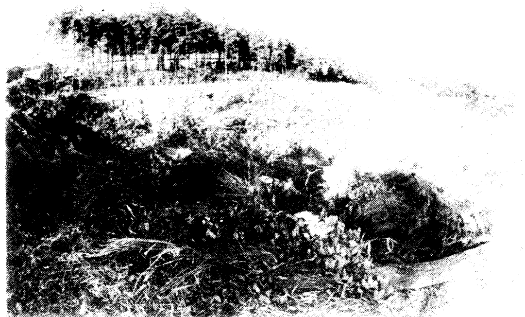
建設予定地南側より北側を眺む
