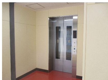
エレベーターも完成しました。
