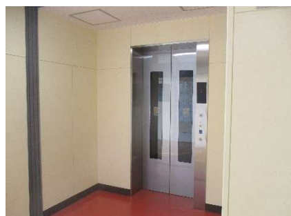
エレベーターも完成しました。
