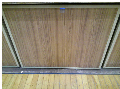
体育館ステージ下修理
