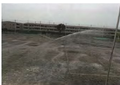
スプリンクラー修繕
