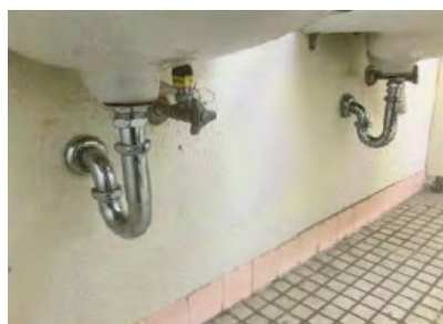
体育館トイレ手洗器修繕
