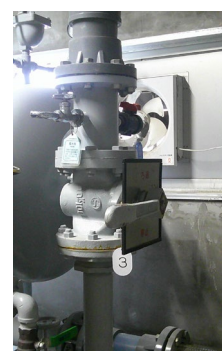
プールろ過機修繕
