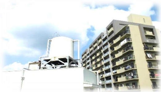
本校屋上の貯水タンク。容量は4㎡。停電・断水になっても、この貯水分は使えます。
