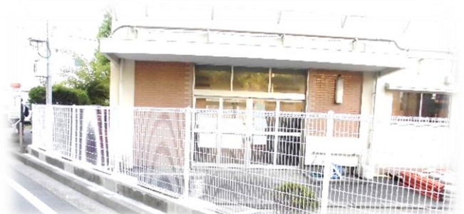
正門側。倒壊の恐れのあるブロック塀が、この夏、フェンスに改修されました。
