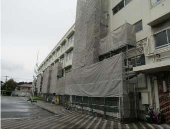
【夏休み中の工事】
