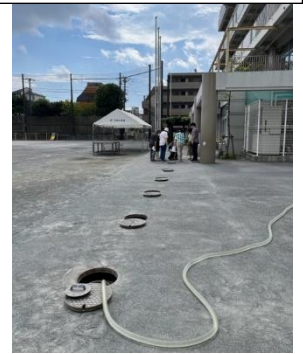
簡易トイレ放水の様子
