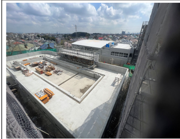
【プール】コンクリート工事（壁・床等）
