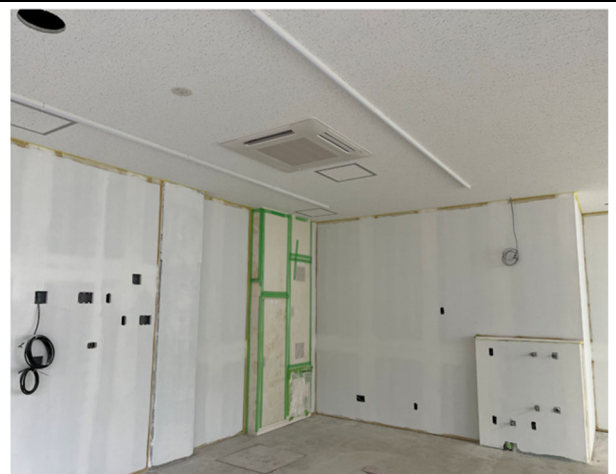
【コミハ棟】内装工事
