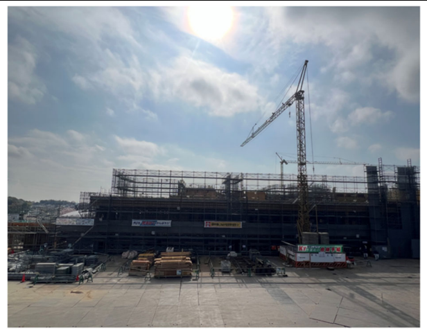
【校舎棟】コンクリート工事（壁・床等）
