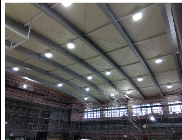
【体育館棟】内装工事
