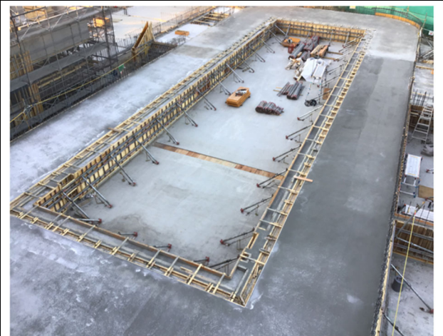
【プール棟】コンクリート工事（本体等）
