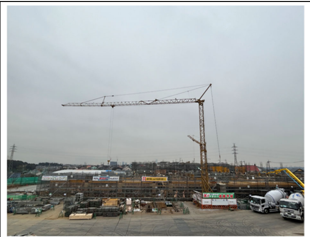
【校舎棟】コンクリート工事（壁・床等）
