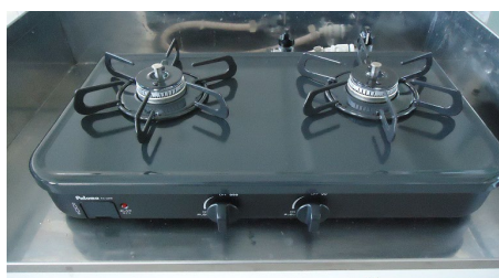
家庭科室ガスコンロ更新
