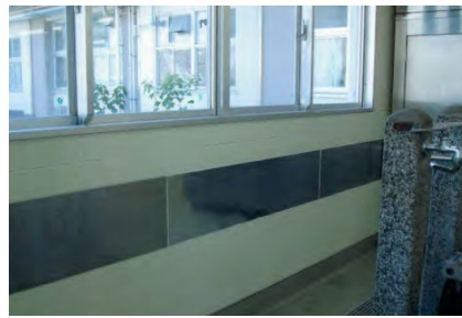
給食室壁面修繕工事
