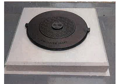
受水槽マンホール取替工事
