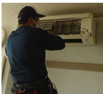
エアコン内部熱交換器清掃
