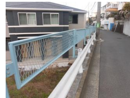
転落防止フェンスの設置
