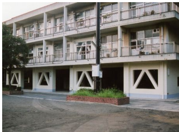
グラウンド方向から見た工事後の校舎
