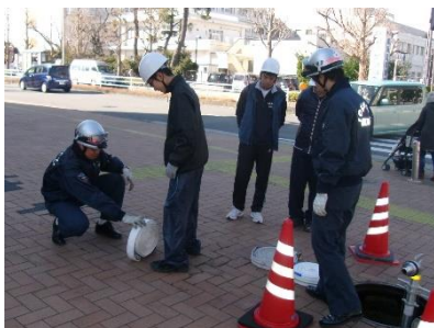
←放水用ホースの出し方について説明を受けています。
