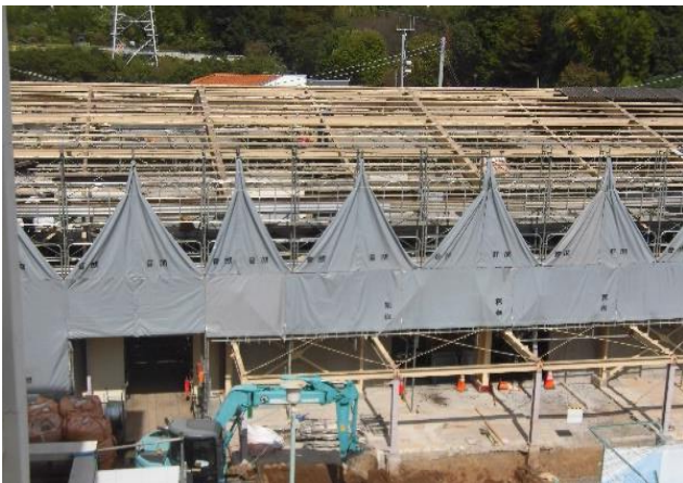
屋根をはがして、鉄筋の部分のペンキの塗り直しや補修をしています。(9/30)
