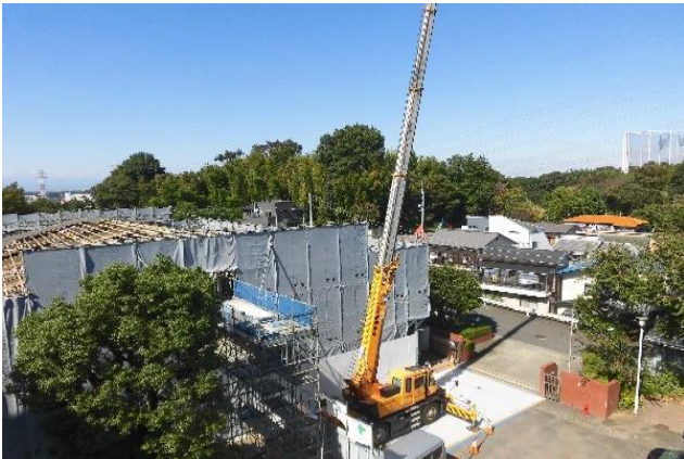
クレーン車で屋根の部分の鉄筋やその他重量のあるものを運び入れています。(9/29)
