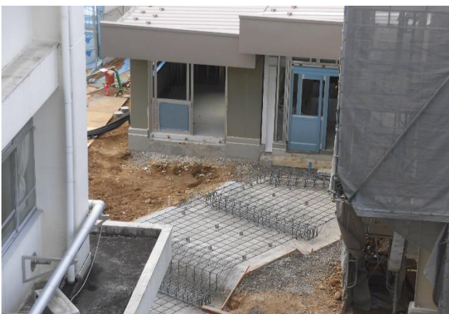
校舎から体育館への渡り廊下の工事です。基礎をしっかり築いています。(1/25)
