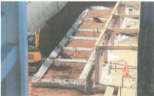
基礎をしっかり築いて、掘り起こした土を埋め戻しています。(11/4)
