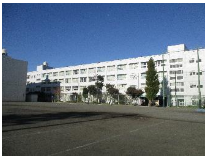
外装工事が終わった校舎
