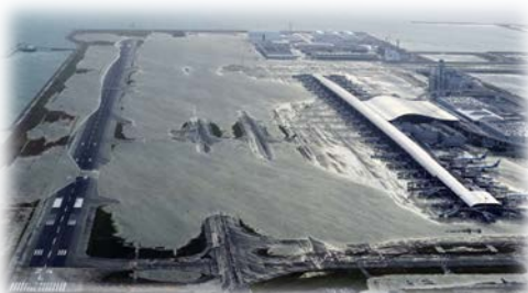
台風21号による被害(2018.9.4)
