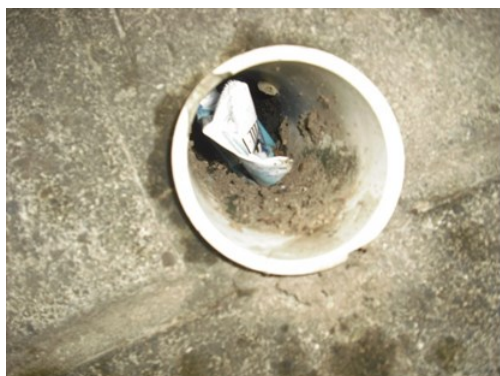
ゴミが学校周りの排水用パイプに詰められています
