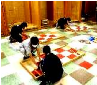
床タイル張り
