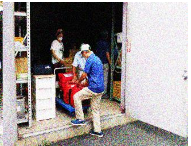
1階の防災備蓄庫、発電機を点検しました。
