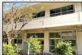
足場が外され、きれいになった外壁が姿を現しました
