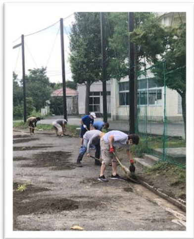
側溝内にたまった泥を掻き出す様子
