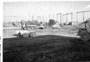
校庭改修工事
