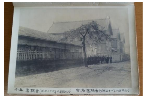
左は明治22年築、右奥は明治31年築の校舎
