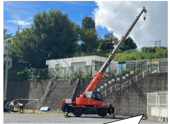
ラフタークレーンで黒土をプール横へ
