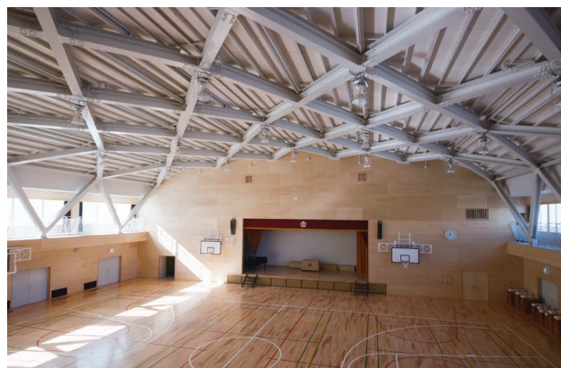
鉄骨の梁もデザイン上の工夫がされている体育館
