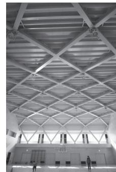
体育館の屋根を支える鉄骨
