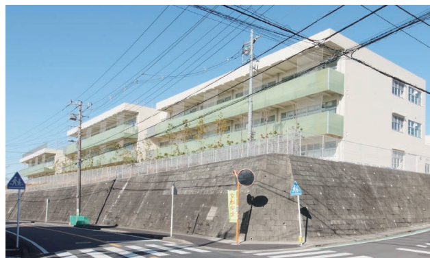
南側外観。バルコニーや校舎内の窓には転落防止に緑色のFRPグレーチングを取付けた。デザインにも活かされている
