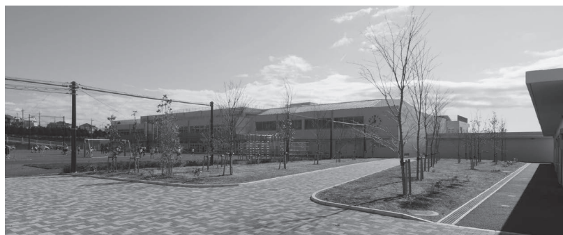
正門からみる美しが丘西小学校校舎。右側には屋外体育倉庫や防災倉庫が並んでいる
