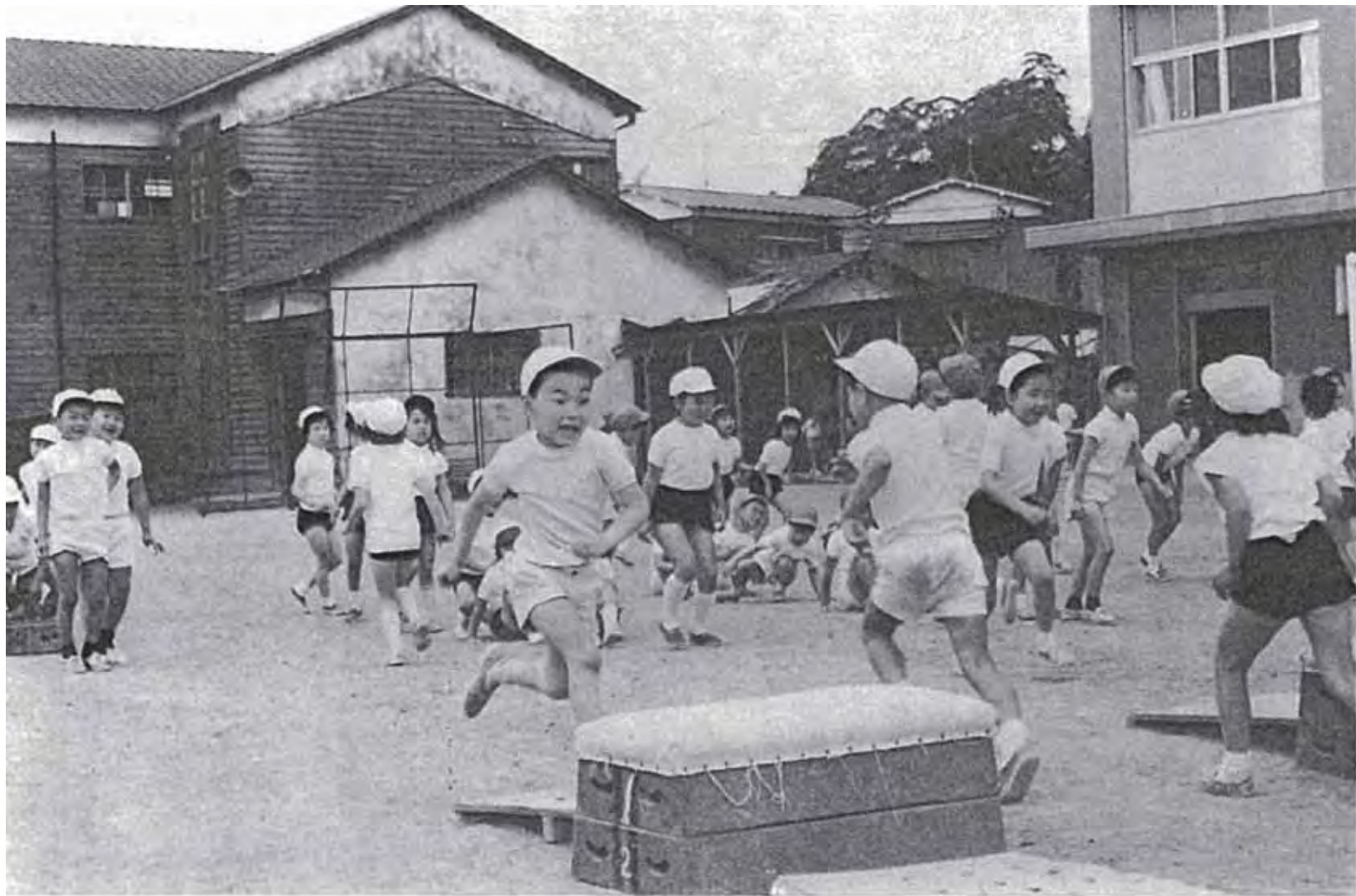
出典:桜岡小学校PTA広報誌 さくらおか, 昭和48年6月20日
