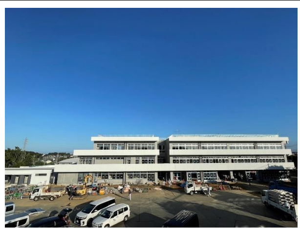
【校舎棟】外構・内装工事
