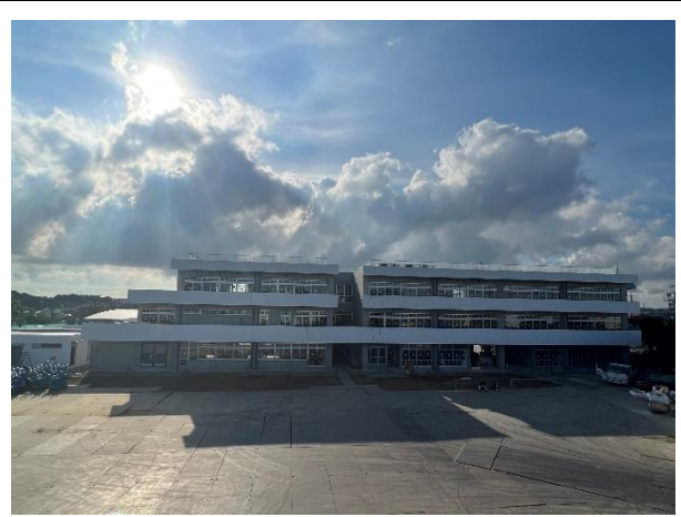
【校舎棟】外装・内装工事
