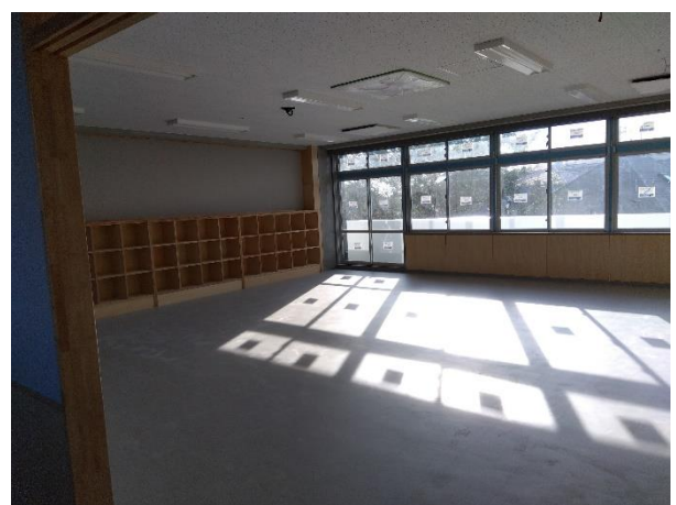
【校舎棟】3階床タイル工事
