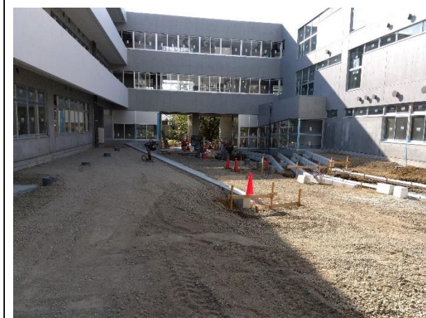
【校舎棟】中庭外構工事
