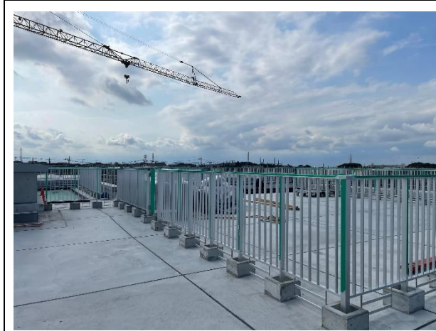
【校舎棟】校舎棟屋上手摺取付
