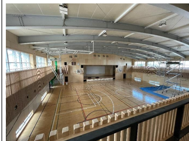
【体育館棟】器具取付
