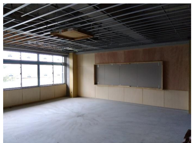
【校舎棟】3階黒板取付工事
