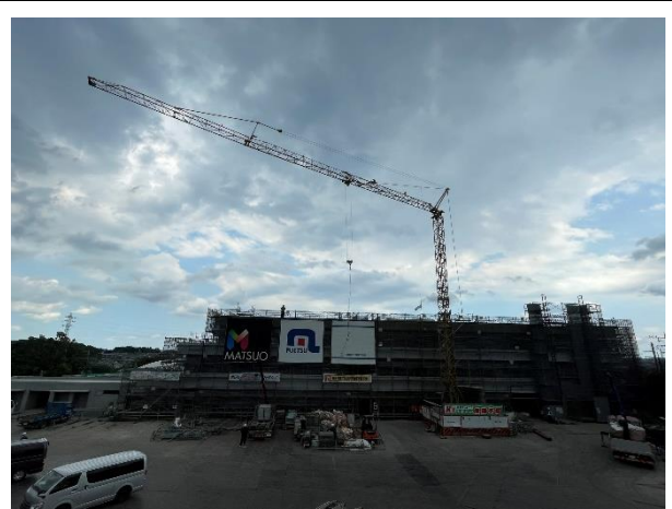
【校舎棟】外装・内装工事
