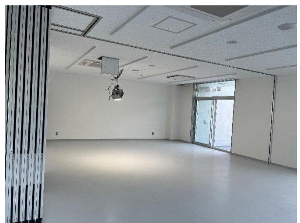
【コミハ棟】内装工事
