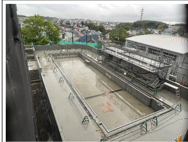
【プール】 コンクリート工事（壁・床等）
