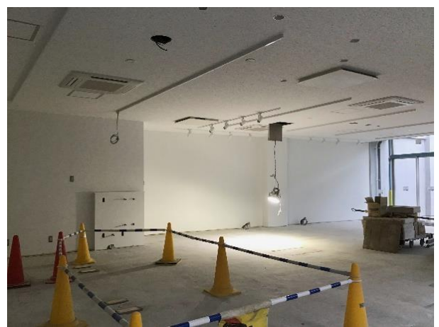
【コミハ棟】 内装工事
