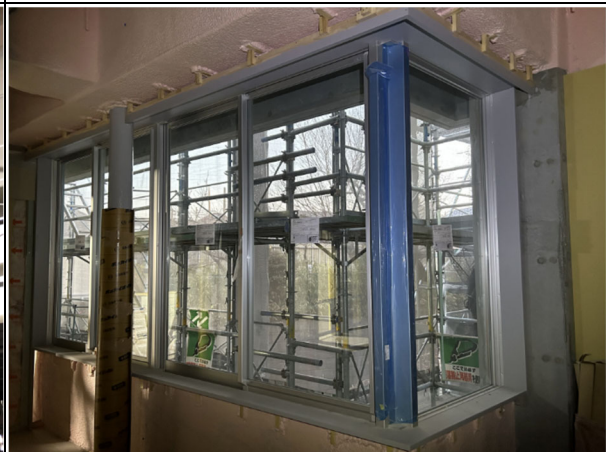
【コミハ棟】内装工事
