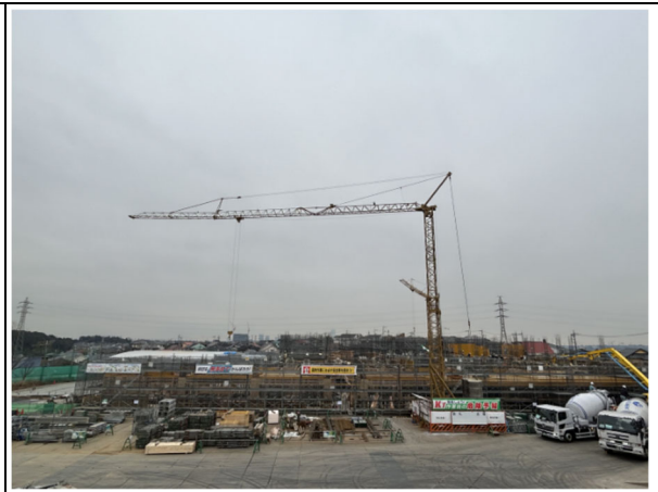
【校舎棟】コンクリート工事（壁・床等）
