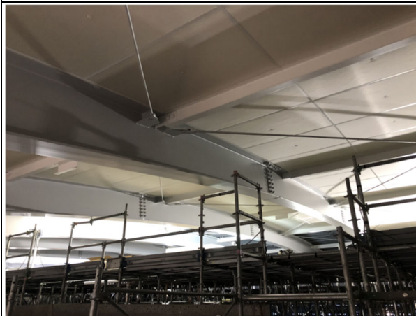
【体育館棟】内装工事
