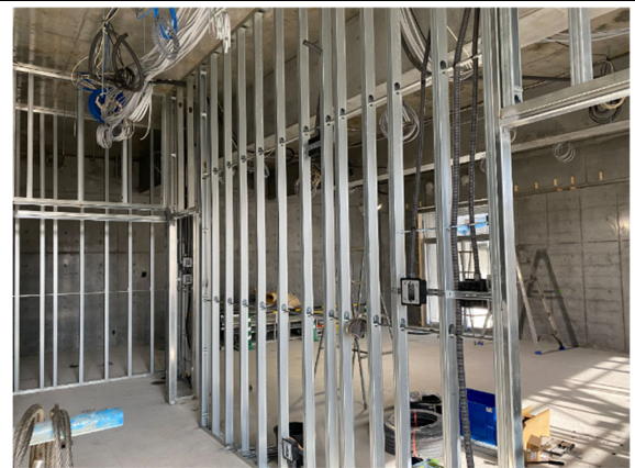
【コミハ棟】屋根防水工事、内装工事
