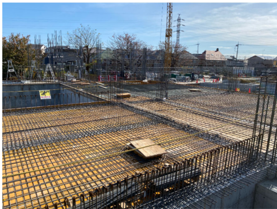
【校舎棟】地上階：床配筋工事
