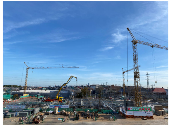
【校舎棟】基礎：コンクリート工事
