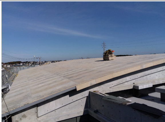
【体育館棟】屋根工事
