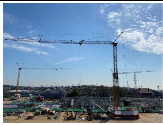
【校舎棟】基礎：鉄筋・型枠・コンクリート
