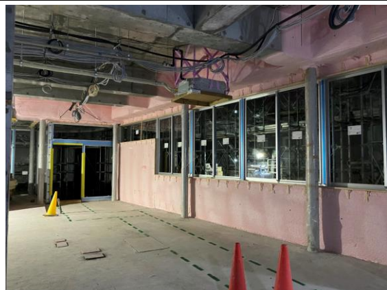
【コミハ棟】内装断熱工事、機器取付け
