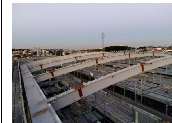
【体育館棟】鉄骨工事
