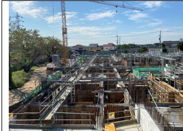
【校舎棟】基礎：鉄筋・型枠・コンクリート
