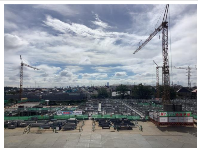
【校舎棟】基礎：鉄筋・型枠工事
