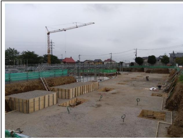
【校舎棟】土工事完了
