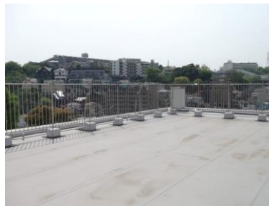
防水用に張り替えた旧校舎屋上
