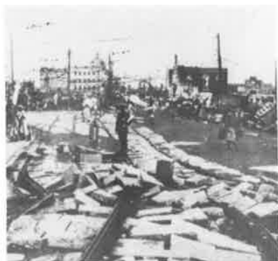
関東大しん災で破かいされた市電のレール （「ちんちん電車」より）
