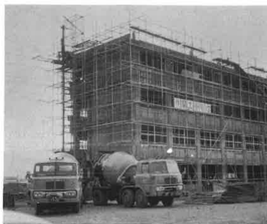
第1期校舎建設
