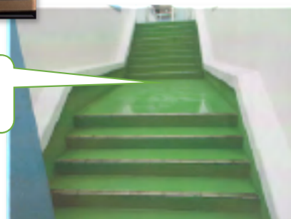
屋上防水塗装工事 (プール階段床)
