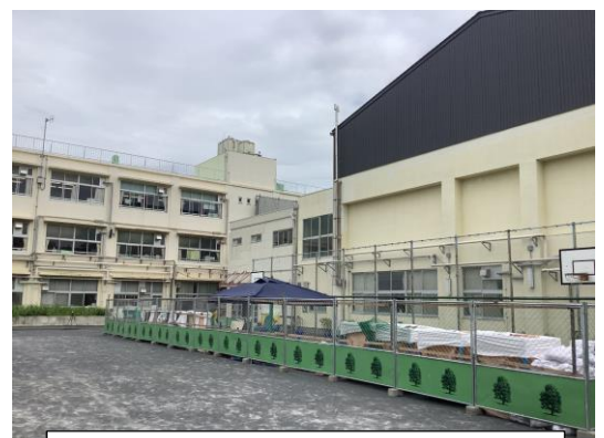
校庭には工事資材置き場の仮囲い
