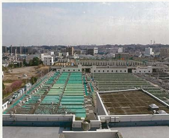
水再生センター全体
