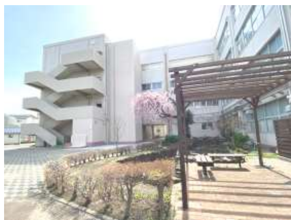
南棟にエレベーター設置
